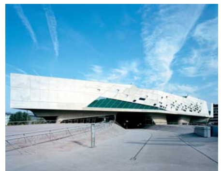
Das architektonisch ambitionierte Science Center „Phaeno“ ist eins der Großprojekte, die die Stadt Wolfsburg aufwerten.
