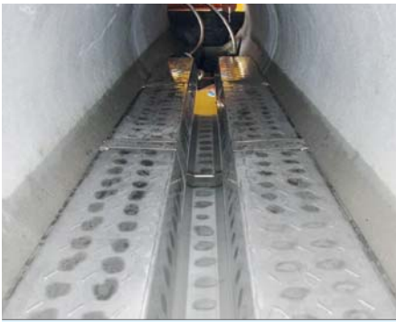
Einbau von Überströmungs-Wärmetauschern im Kanal zur Rückgewinnung von Wärmeenergie aus Abwasser
